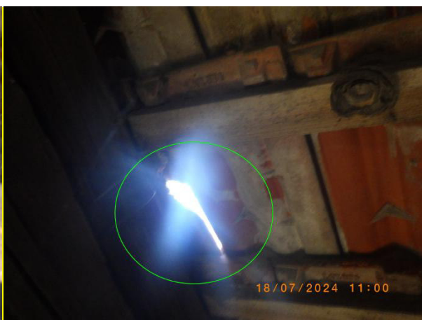
foto 79 poškození od dřevokazného hmyzu foto 80 netěsnost krytiny
