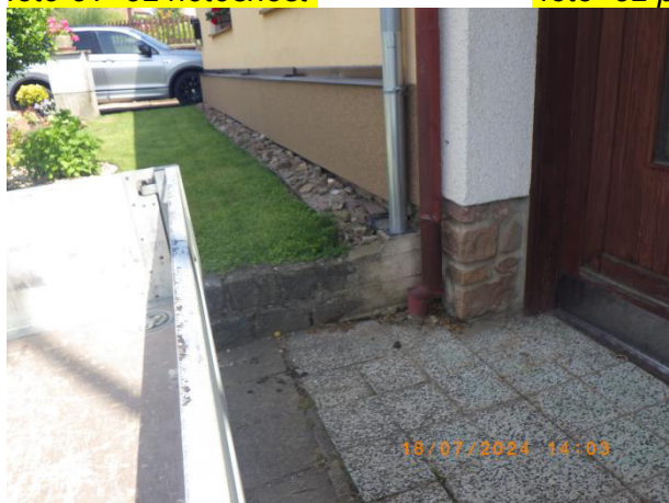
foto 83 schází lapač střešních splavenin
