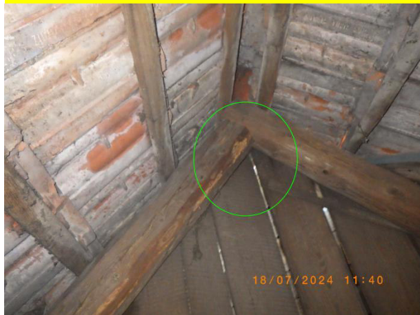
foto 98+99 poškození částí krovu od dřevokazného hmyzu, zatékání foto 99
