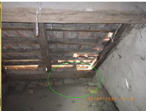
foto 75 střecha bez pojistné hydroizolace a zateplení foto 76 poškozené zdivo
