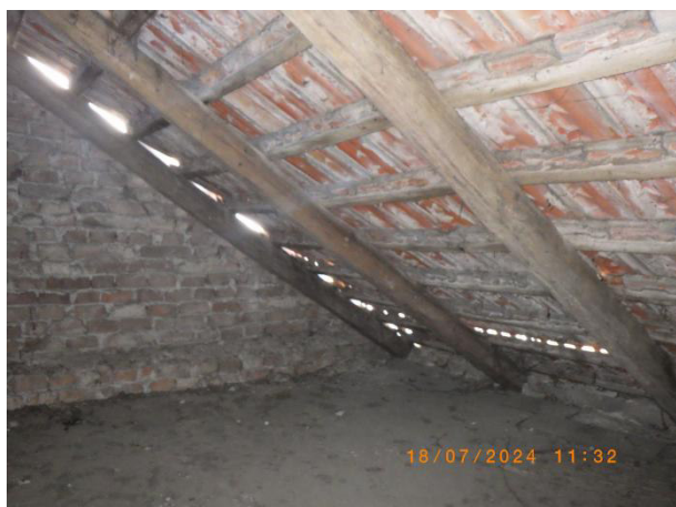
foto 90+91 půda P3 bez zateplení, bez pojistné hydroizolace
