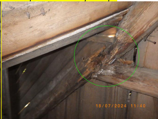
foto 98+99 poškození částí krovu od dřevokazného hmyzu, zatékání foto 99
