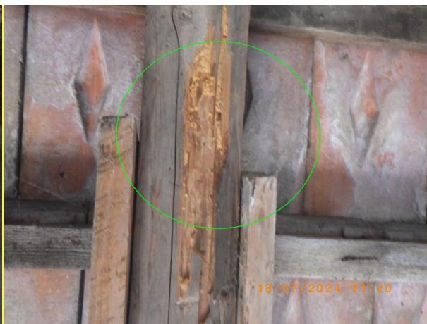
foto 87 půda P2 poškození od dřevokazného hmyzu
