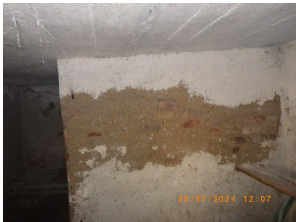
foto 102 +103 0.01 sklep 1 poškozené povrchy od vlhkosti
