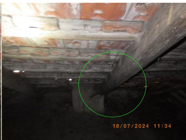
foto 90+91 půda P3 bez zateplení, bez pojistné hydroizolace
