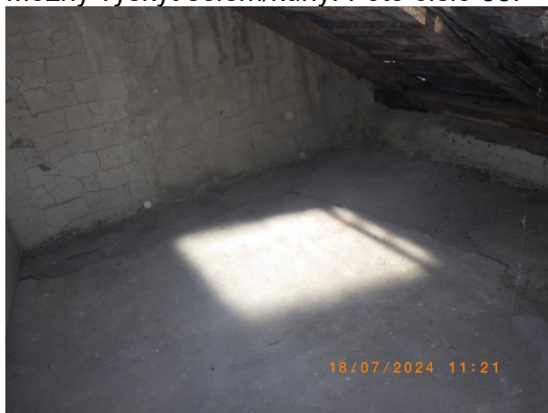
foto 86 půda P2 poškozené omítky
