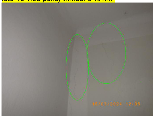
foto 17 1.03 pokoj trhlina v místě stěny/stropu
