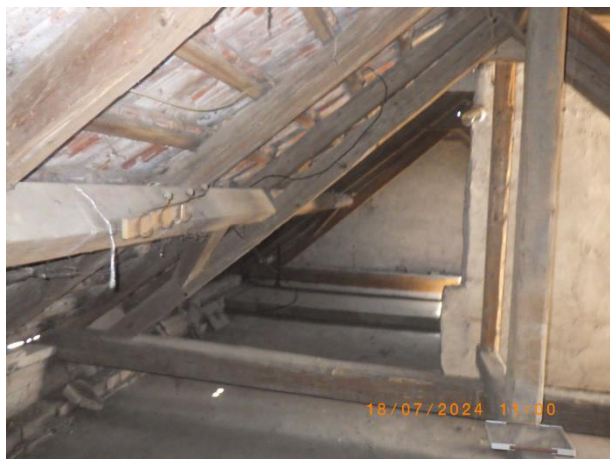
foto 75 střecha bez pojistné hydroizolace a zateplení foto 76 poškozené zdivo
