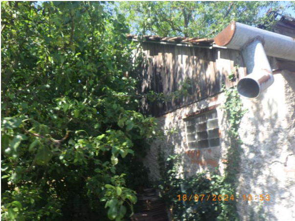
foto 117 schází zaústění svislého svodu
