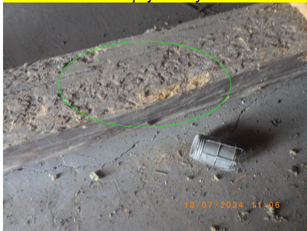
foto 77 + 78 poškození od dřevokazného hmyzu
