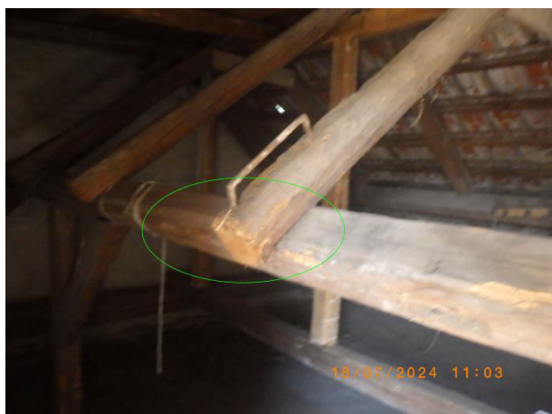
foto 79 poškození od dřevokazného hmyzu foto 80 netěsnost krytiny
