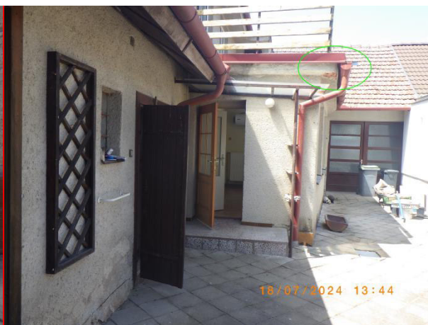
foto 93 poškození římsy, dlažby
