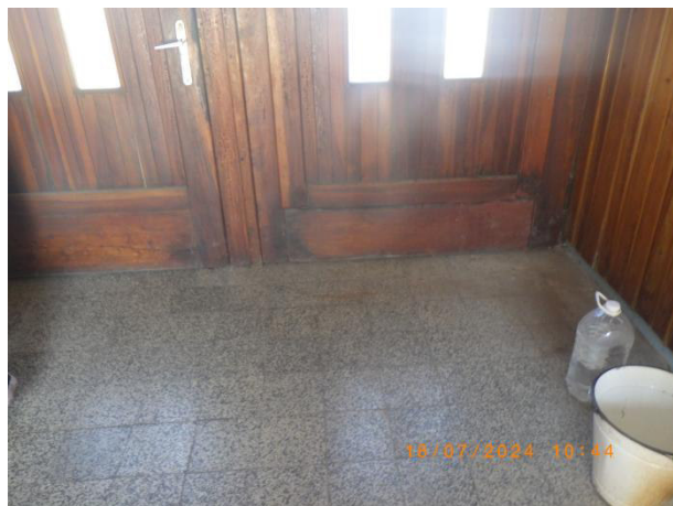
foto 01 1.01 průjezd původní dlažba, vrata
