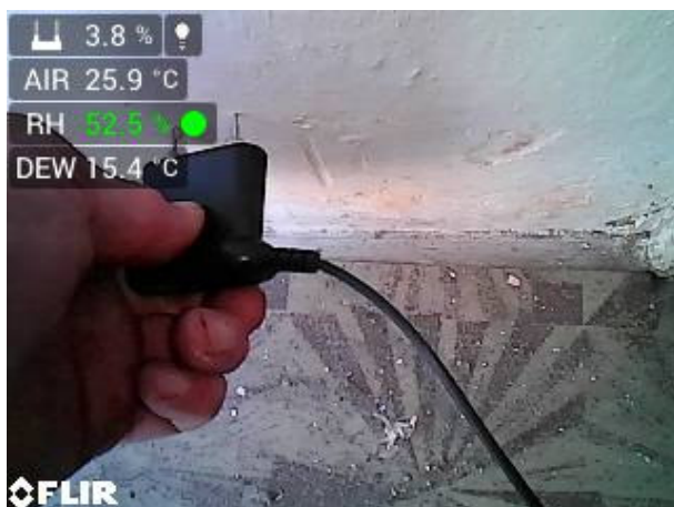
foto 51 1.11. chodba vlhkost 3,8 % hm
